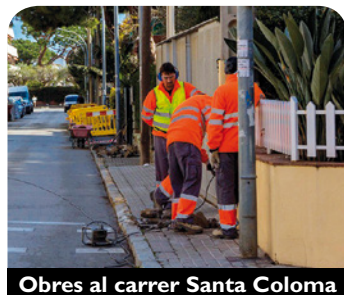
Obres al carrer Santa Coloma
