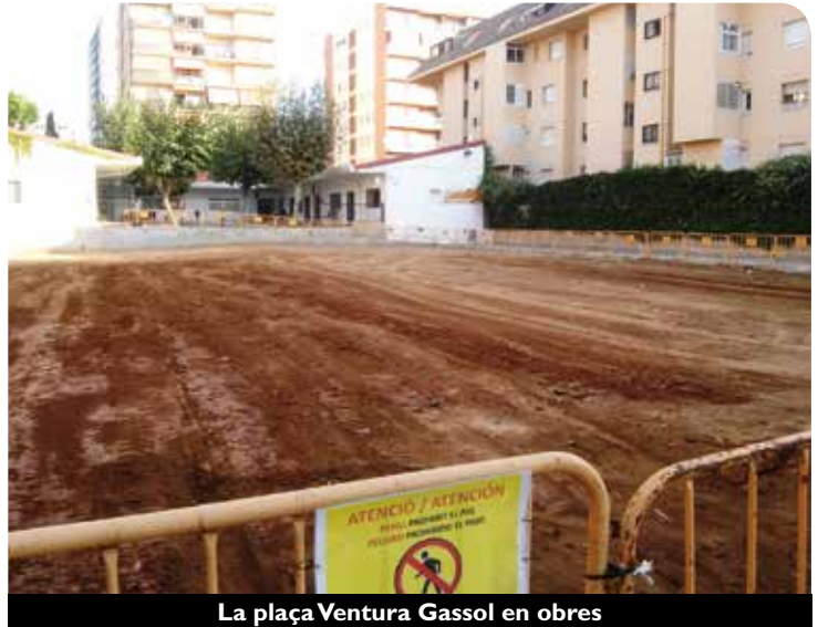
La plaça Ventura Gassol en obres
