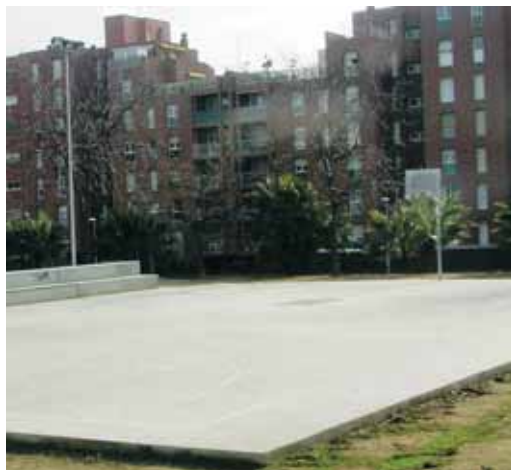
Estat de la pista abans de l'actuació
