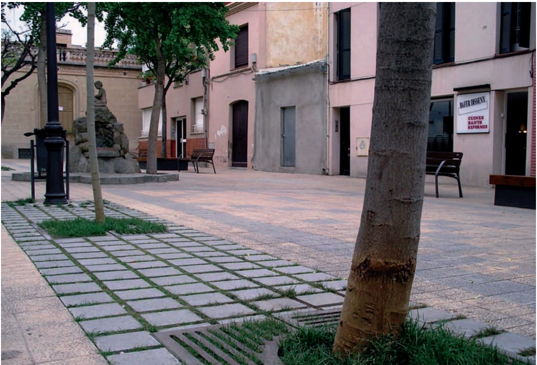
Nou paviment de lloses de formigó amb una junta de gespa al mig
