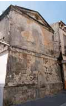
Estat actual de la torre del telègraf òptic
