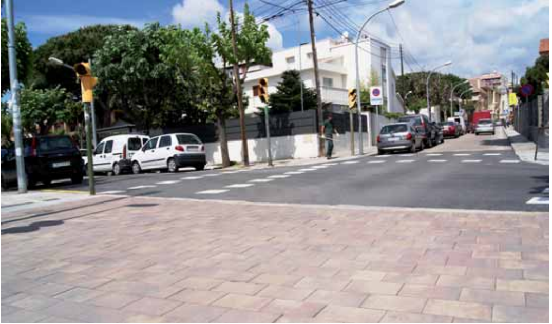
La unió del carrer Sant Joan i el carrer Colom s'ha resolt amb un desnivell pràcticament imperceptible
