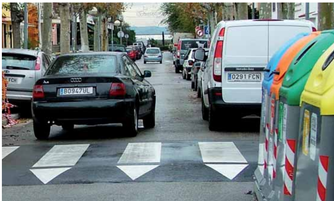
Nou pas elevat de vianants al carrer Lluís Jover
