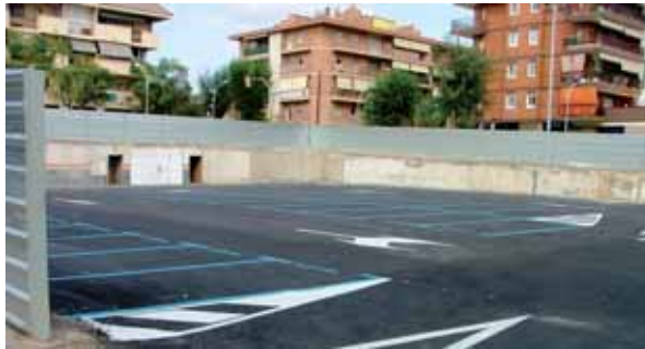
Aparcament habilitat al solar del Mercat.
