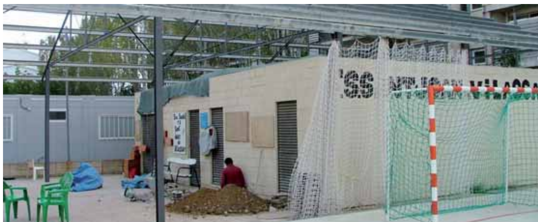
Obres als vestidors i coberta de la pista Lluís Guardiola.
