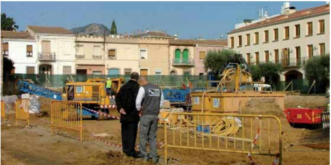
L'aparcament està en fase de construcció.
