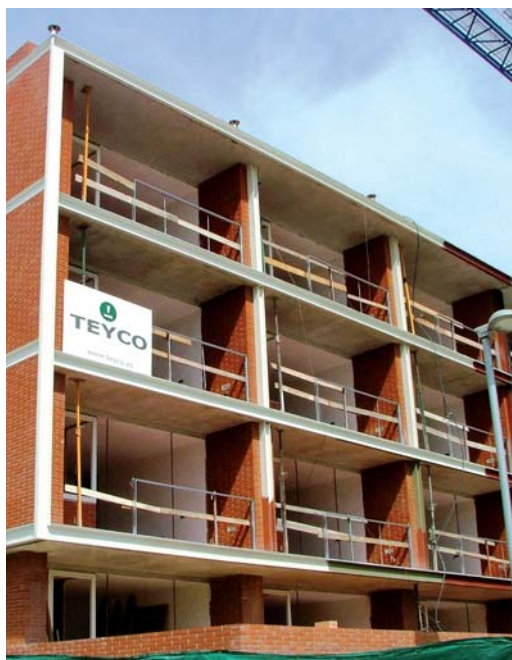
Els 12 pisos estan en fase de construcció
