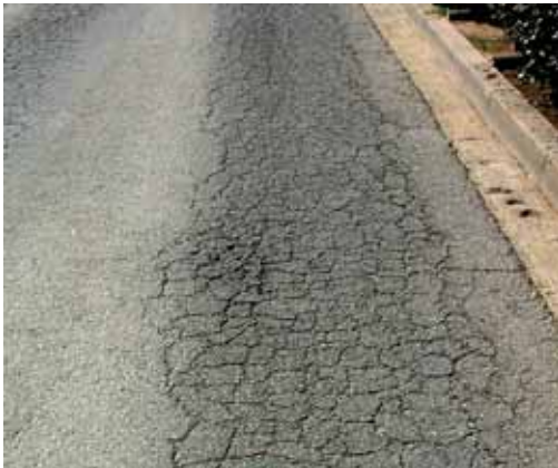
Amb les obres, les esquerdes de la calçada de Santa Eulàlia han desaparegut
