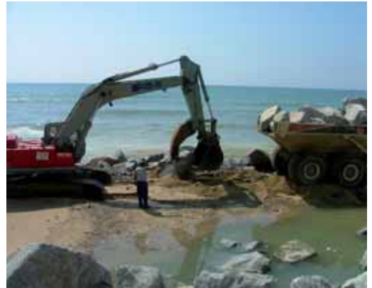
Operaris treballant en la nova escullera
