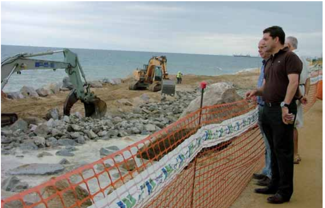
L'alcalde i el regidor d'Urbanisme visiten les obres del passeig
