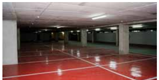
Interior del nou aparcament
