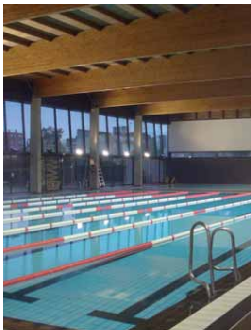
S'han arranjat les filtracions dels vasos
