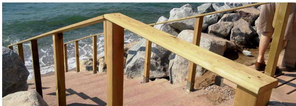
S'estan reparant les escales malmeses
