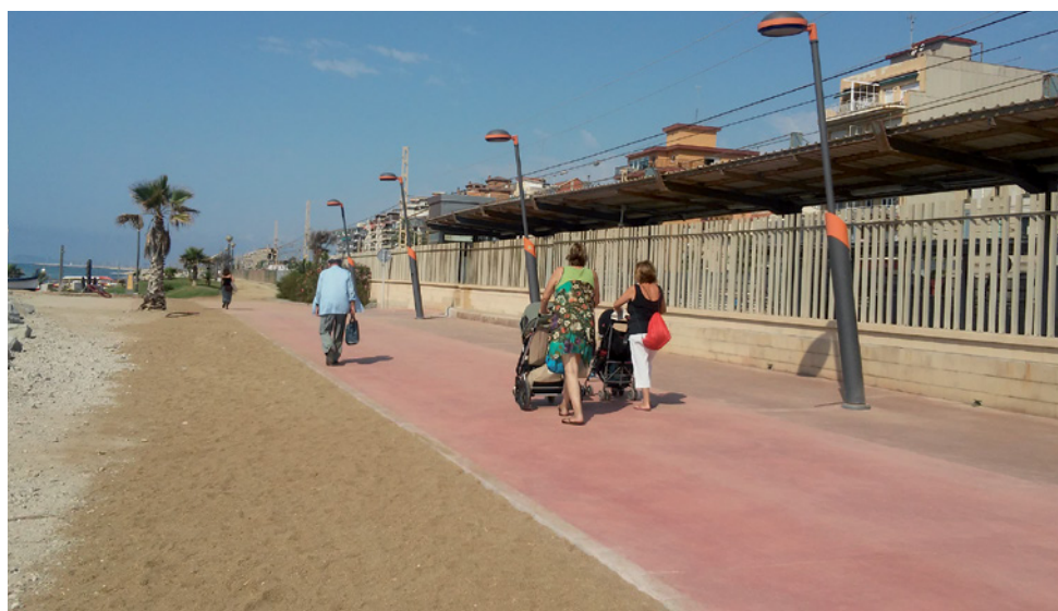
El paviment malmès s'ha canviat per una llosa contínua de formigó donant uniformitat al conjunt
