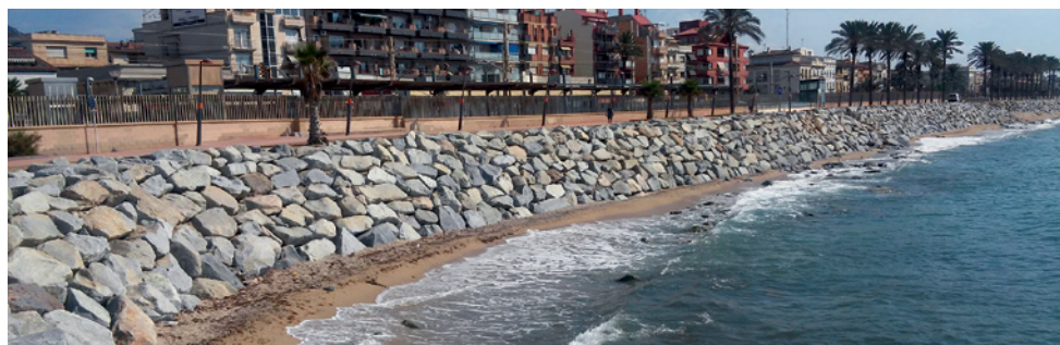
L'escullera s'ha reforçat amb unes 7.000 tones de pedra per fer-la més segura
