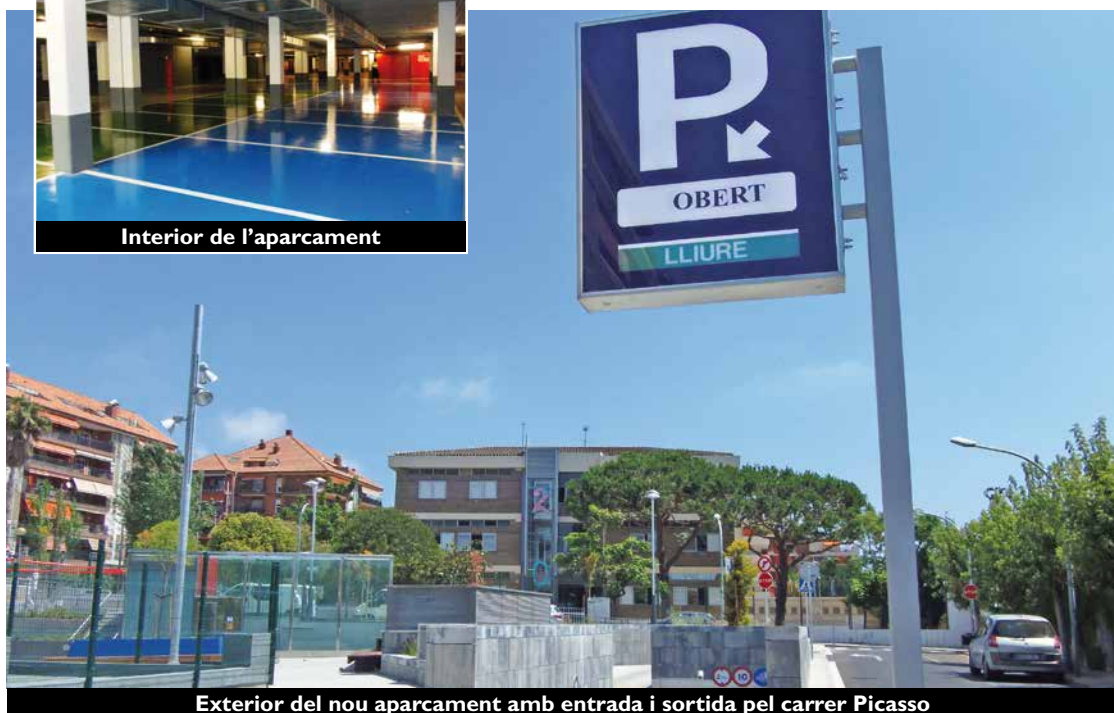
Exterior del nou aparcament amb entrada i sortida pel carrer Picasso
