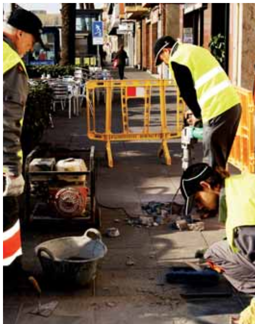
Tres dels contractats, arranjant el paviment del carrer Sant Jaume
