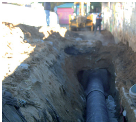
Reparació del col·lector
