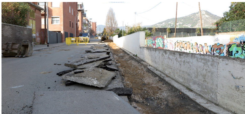
Inici de l'obra, el 9 de gener
