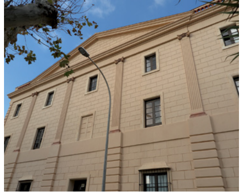
Una de les façanes restaurades
