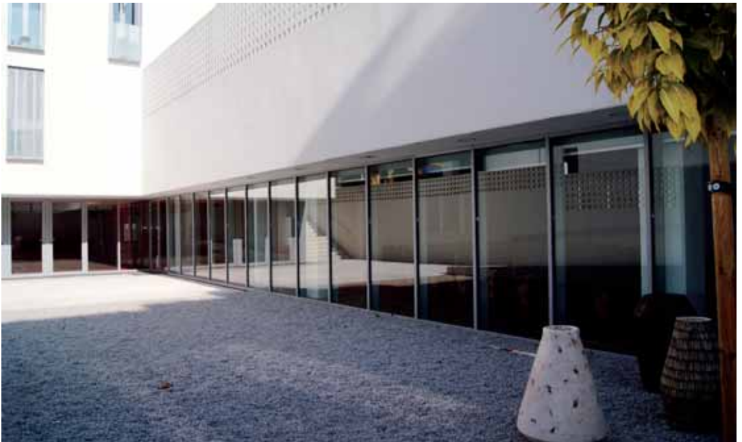
Exterior de l'equipament
