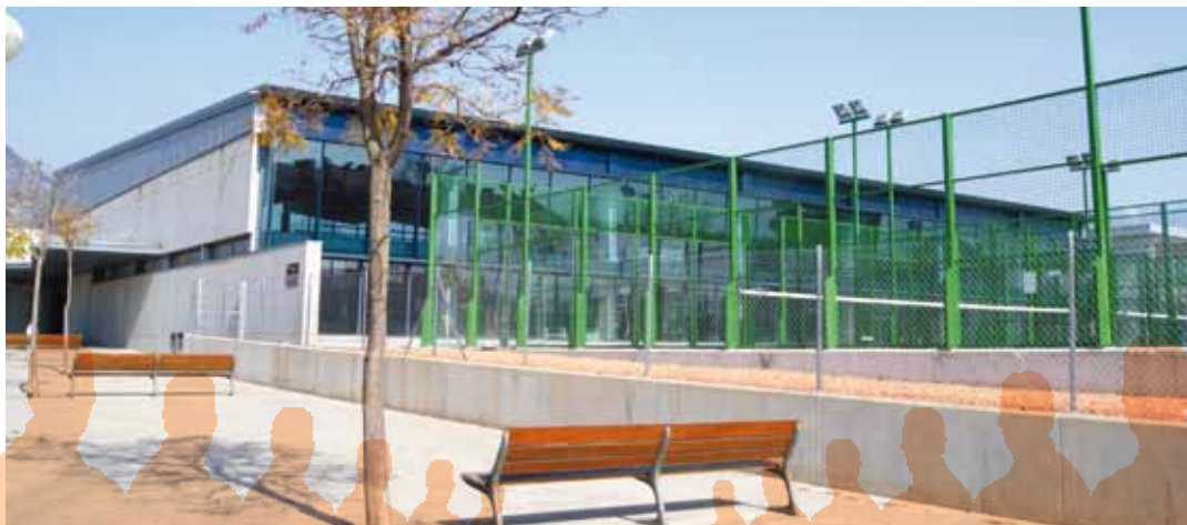
Exterior de la Piscina Municipal
