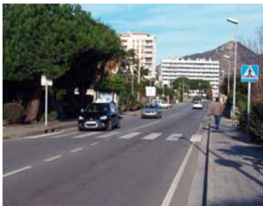
Es construiran guals de vianants a tots els passos de vianants
