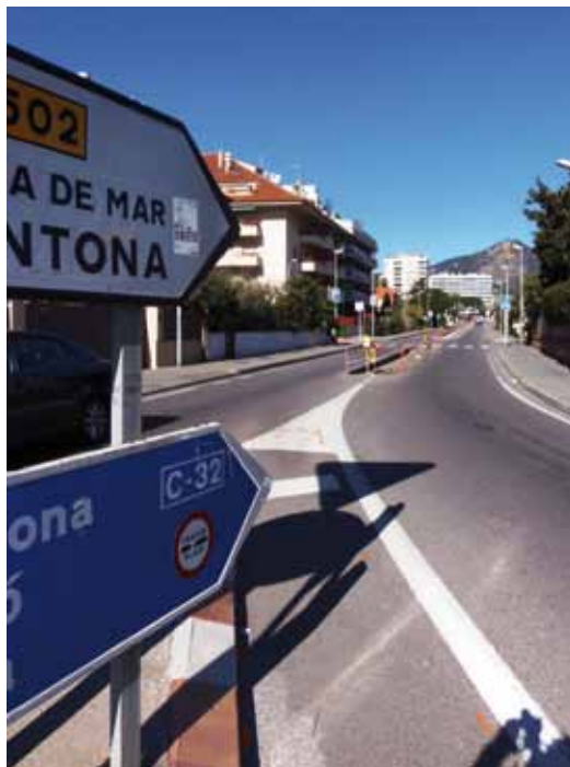
Vista general de la carretera des de l'N-II, durant les obres
