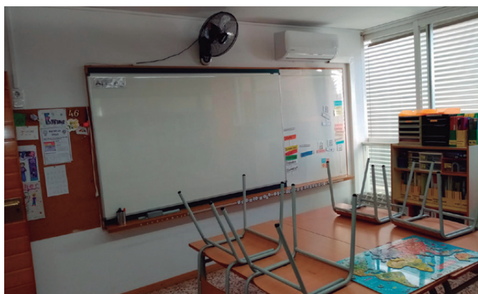
Instal·lació d'aire condicionat a dues aules de l'escola Vaixell Burriac
