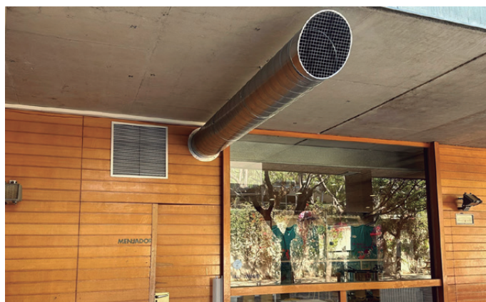
Instal·lació d'un recuperador entàpic al menjador de l'escola Vaixell Burriac per garantir una ventilació eficient
