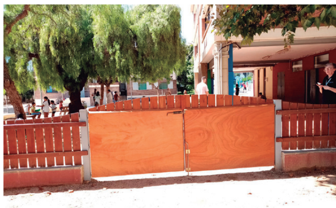
Instal·lació porta d'accés de vehicles al pati de la Suïssa de l'escola Pérez Sala
