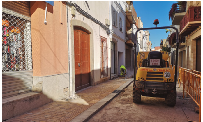
Obres d'accessibilitat al carrer Sant Sebastià
