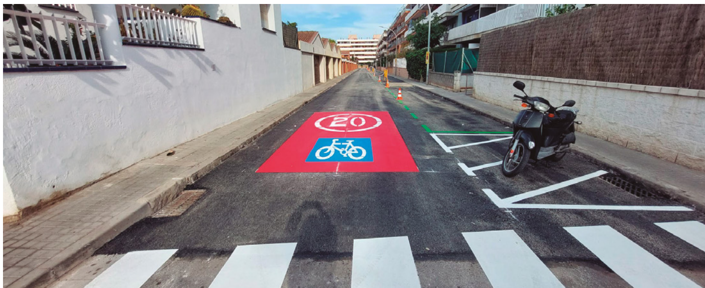
Reasfaltat fet al carrer Rosari, entre Riera d'en Cintet i carretera d'Argentona
