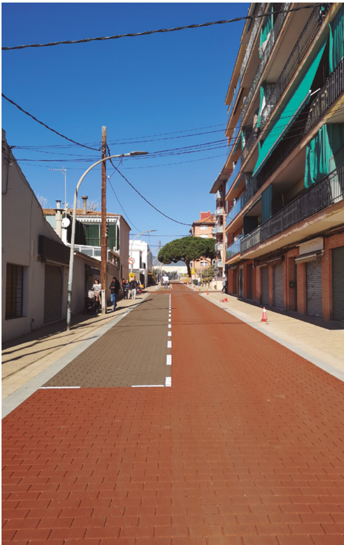
Imatge del tram del carrer reurbanitzat, a data de 17 de febrer
