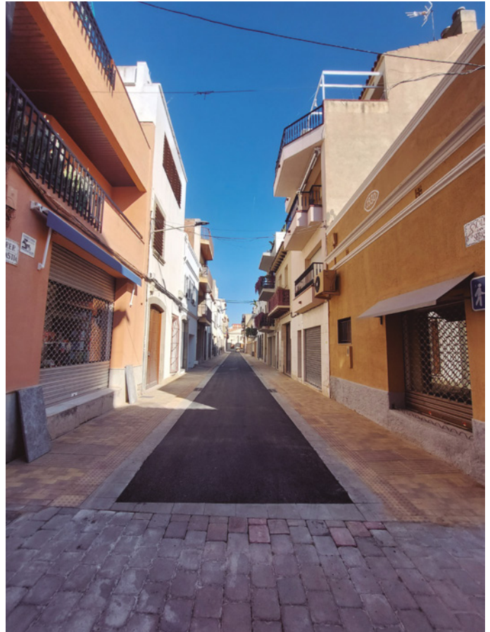
Carrer Sant Sebastià, abans de la imprimació de l'asfalt
