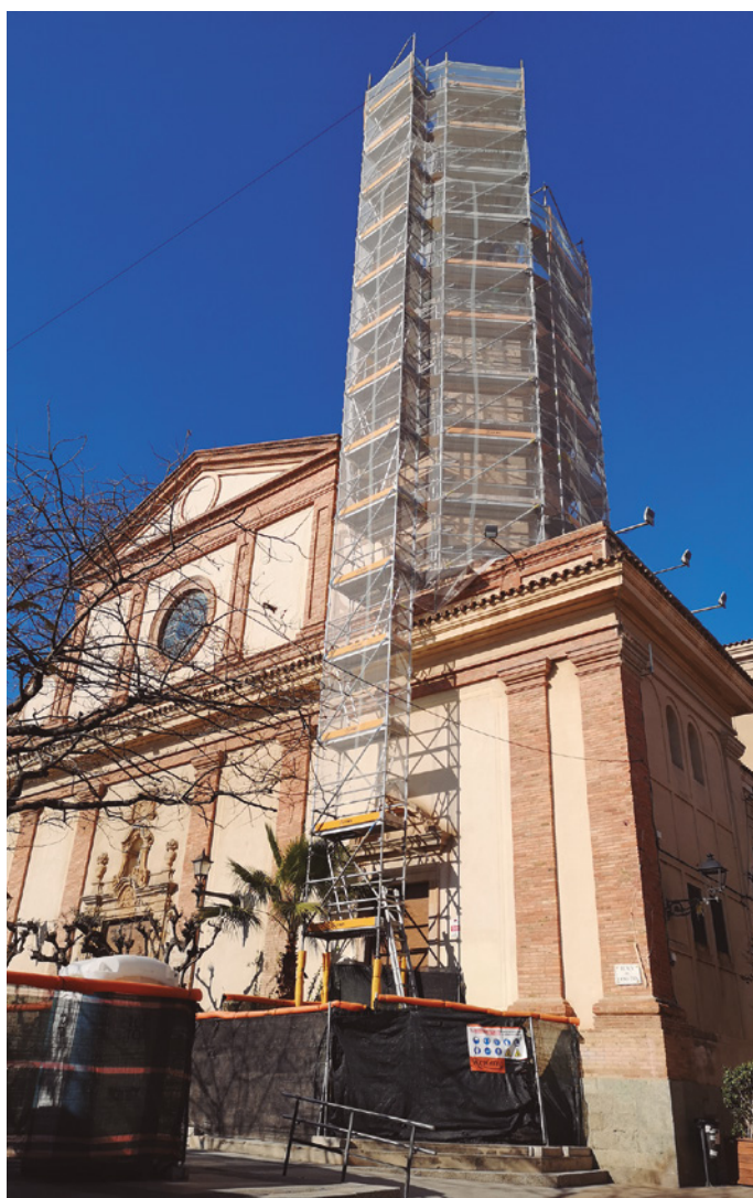
El campanar de l'Església amb la bastida de les obres
