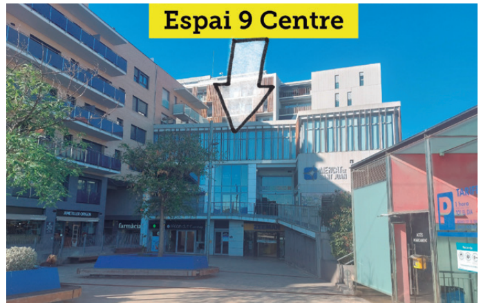
Es troba ubicat a la primera planta de l'edifici del Mercat
