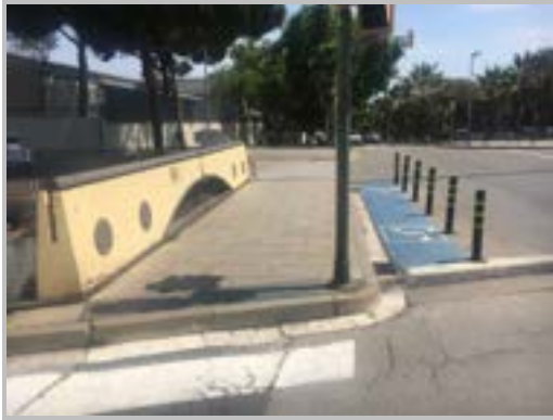
Imatge 29. Espai dedicat a persones amb mobilitat reduïda a l'av. Arquitecte Eduard Ferrés amb Riera d'en Cintet. Font: AIM, elaboració pròpia.
