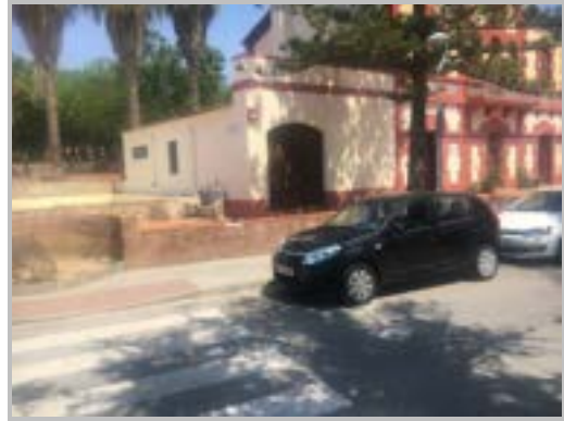
Imatge 30. Pas de vianants sense visibilitat i sense gual adaptat a l'av. Arquitecte Eduard Ferrés amb el pg. de Sant Joan de Mar. Font: AIM, elaboració pròpia.
