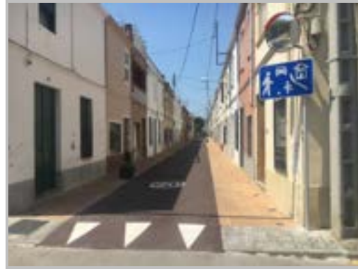
Imatge 6. Carrer de Sant Ramón de plataforma única. Font: AIM, elaboració pròpia.
