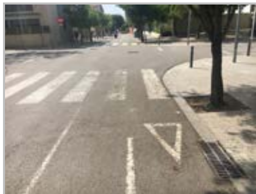
Imatge 14. Mala senyalització al encreuament amb carrer Santa Eulàlia. Font: AIM, elaboració pròpia.
