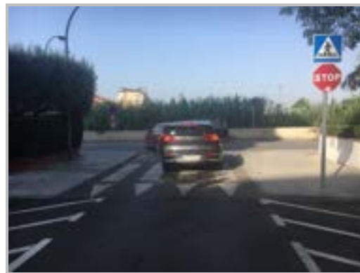
Imatge 26. Pas de vianants elevat amb bona visibilitat al carrer Santa Maria amb ronda Vilassar. Font: AIM, elaboració pròpia.
