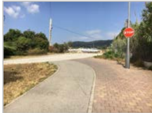
Imatge 20. Extrem de la vorera bici sense connexió. Font: AIM, elaboració pròpia.
