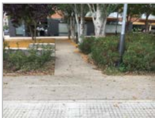
Imatge 16. Manca de senyalització d'escaquer als trams amb conflicte amb els vianants. Font: AIM, elaboració pròpia.
