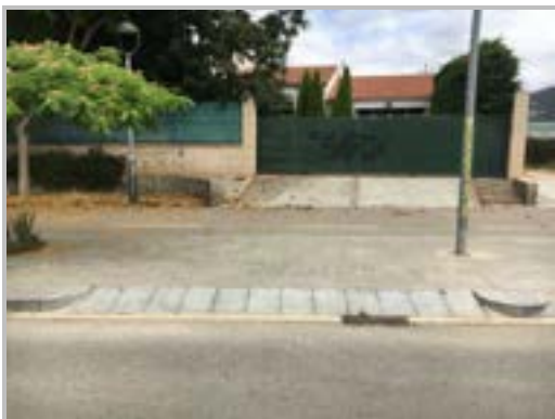
Imatge 21. Vorera bici a una entrada per vehicles. Font: AIM, elaboració pròpia.
