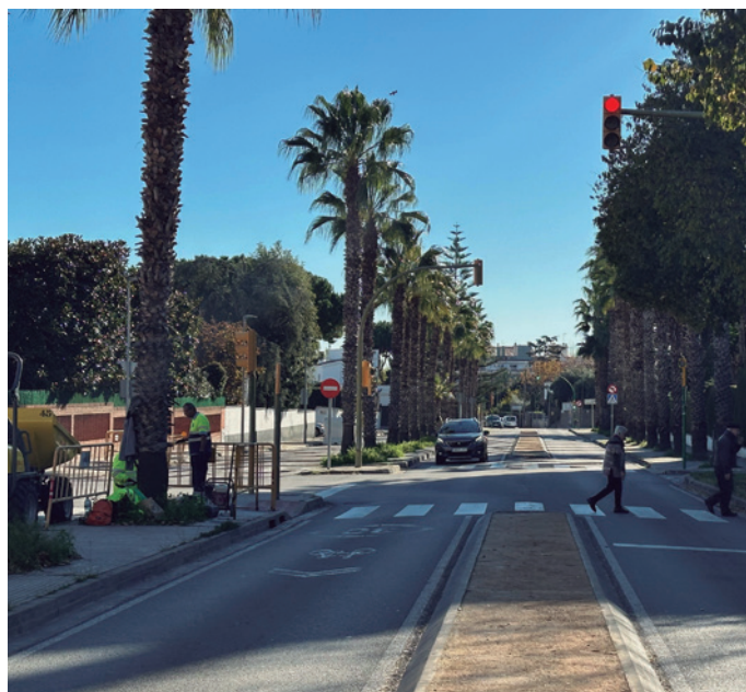
Operaris durant les obres de canalització dels nous punts de llum
