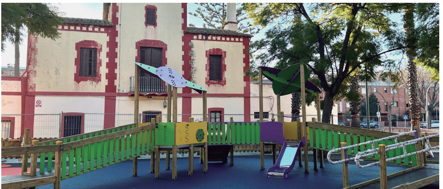
Les obres del projecte de renovació del parc de la plaça Tarradellas amb una mirada inclusiva es troben a la fase final
