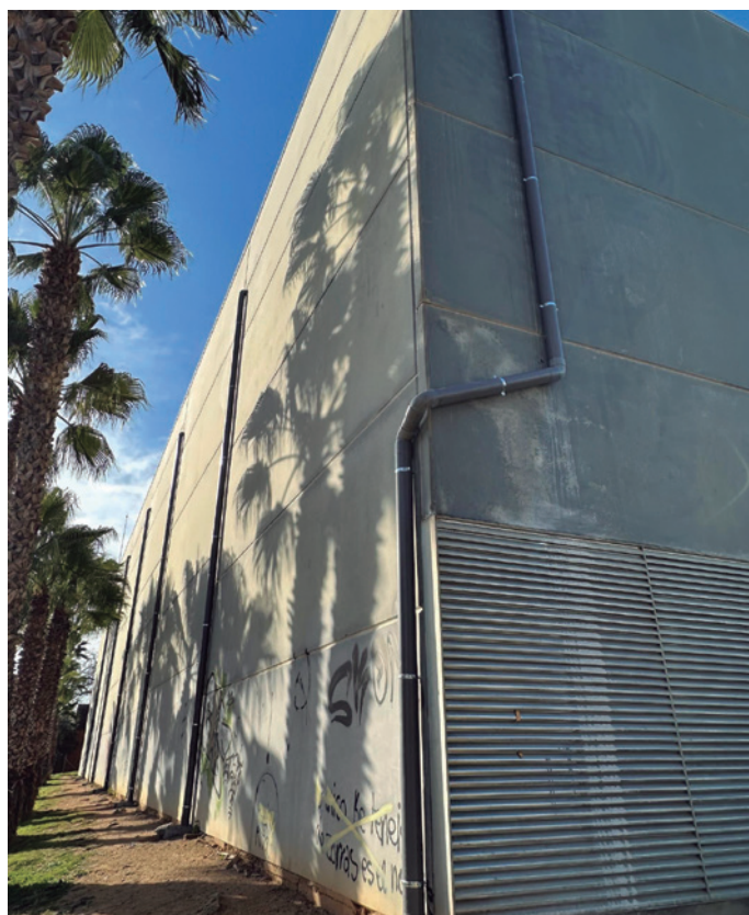
Nous drenatges pluvials
